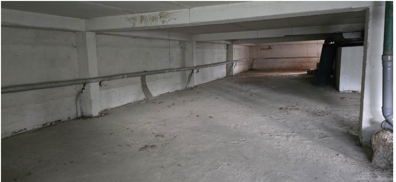
Рисунок 4 – Загальний вигляд фрагменту технічного поверху
