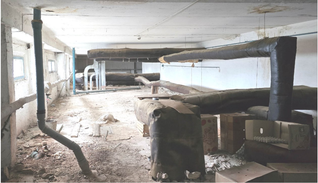
Рисунок 6 – Сліди замочування від доремонтних протікань в місцях кріплення інженерних систем на технічному поверсі, будівельне сміття на підлозі
