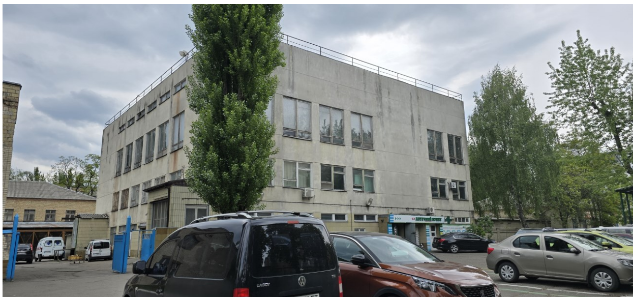
Рисунок 2 – Загальний вигляд будівлі корпусу харчоблоку
